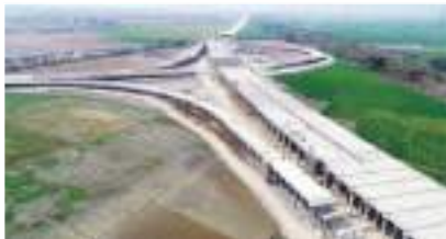
Proyek Tol Cibitung Cilincing
