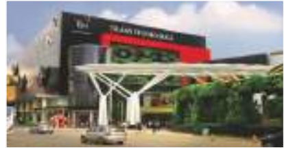
Proyek Gedung Trans Studio
