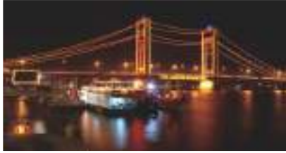
Proyek Jembatan Ampera
