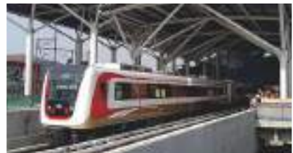
Proyek LRT Jakarta
