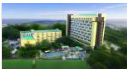
Proyek Hotel Lorin Sentul
