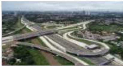
Proyek Tol Patimban
