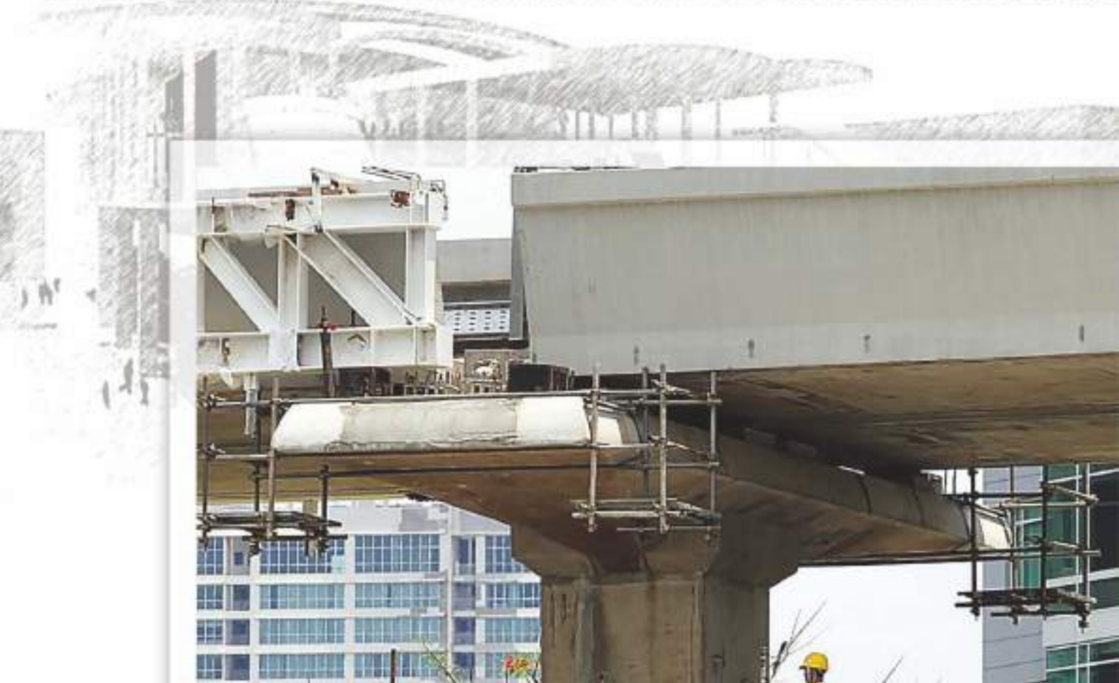
PROYEK LRT JAKARTA - DKI JAKARTA
