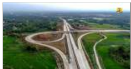
Proyek Tol Probolinggo - Banyuwangi
