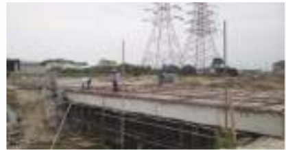
Proyek Jembatan KIEC Antartika 1
