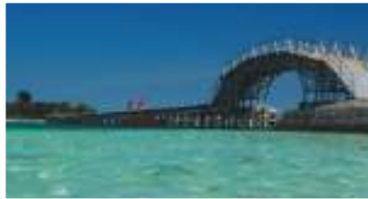
Proyek Jembatan Marina
