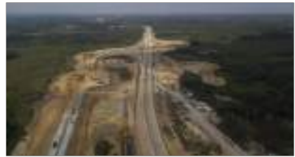
Proyek akses Tol IKN
