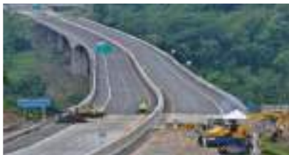
Proyek Pembangunan Jalan Ciawi Sukabumi
