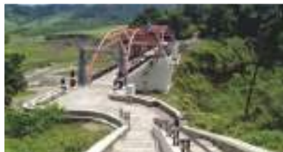
Proyek Waduk Jati Barang Semarang
