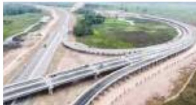
Proyek Tol Cibitung Cilincing
