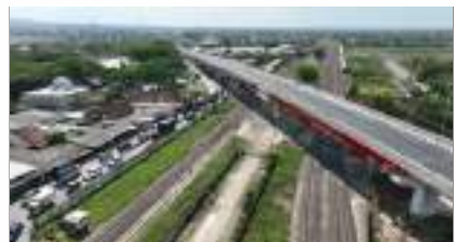
Proyek Jembatan Ganefo
