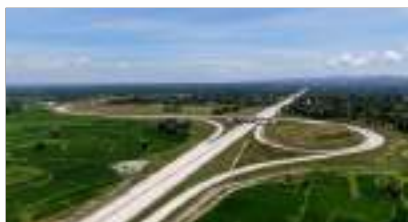
Proyek Tol Trans Sumatera Ruas Binjai
