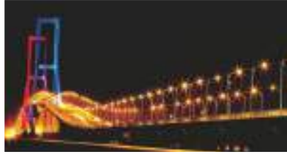
Proyek Jembatan Suramadu
